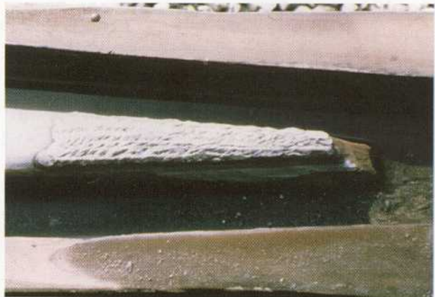
figuur 9.13 Puntstuk van een wissel in de spoorweg bovenbouw
