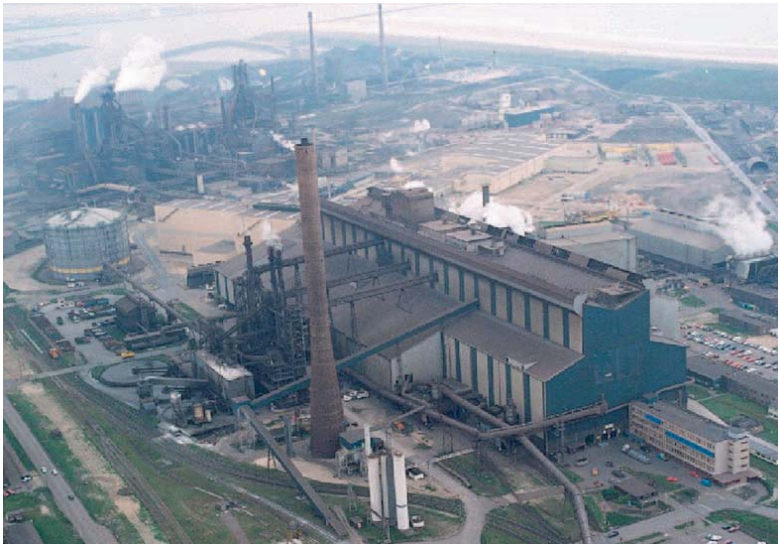
Oxystaalfabriek Corus in IJmuiden, met drie converters goed voor een jaar- productie van 6,9 miljoen ton staal
