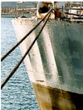
Figuur 1: Doordieping (bukkeling) van de staalplaat tussen de verticale en horizontale verstijvingsprofielen ten gevolge van laskrimp is duidelijk zichtbaar in de boeg van dit schip.
