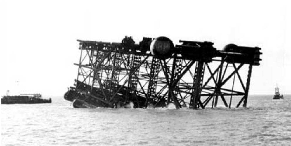
Foto 1: Gevolg van een lamellaire scheur, veroorzaakt tijdens het reparatie lassen van een onvolkomen doorlassing.
